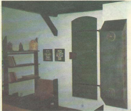
3. Topné těleso v podkroví: 1 – kovové těleso (může být nahrazeno keramickým topidlem); 2 – vymetací otvor; 3 – klapka; 4 – komínová klapka (obě klapky se ovládají zvenku a lze jimi seřídit optimální tah spalin z komína do tělesa); 5 – zděh; 6 – trubkové výměníky tepla v tělese.
